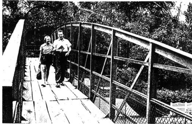
2. ábra A balatonszemesi hegesztett felüljáró
