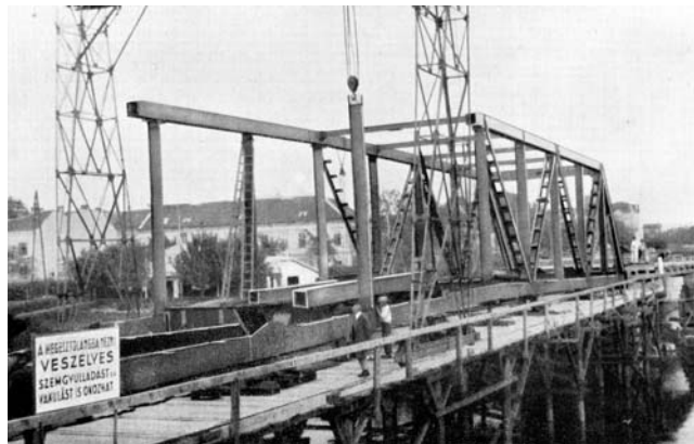
3. ábra Győri Közüti Rábahíd szerelése (Magyar Waggon- és Gépgyár Rt. Győr-Budapest)
