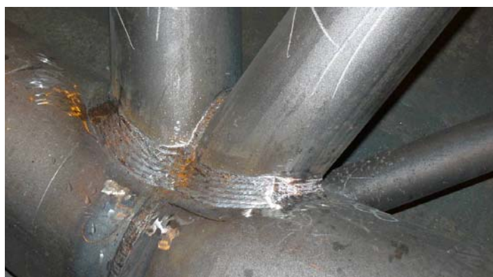
24. ábra Rácsrudak átlapolt kötés kialakítással
