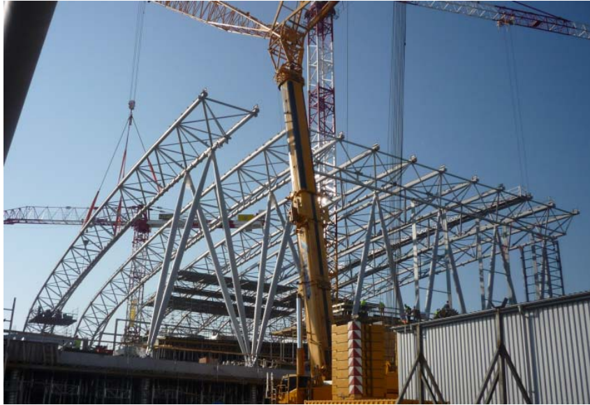
32. ábra A földön összehegesztett tagok beemelése (2,3,4)
