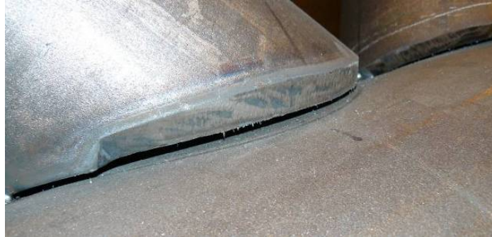
18. ábra: Varrat előkészítés rácsrudak bekötésénél
