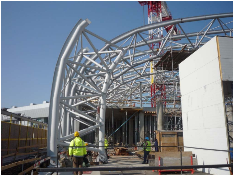
31. ábra Az íves egység elhelyezése
