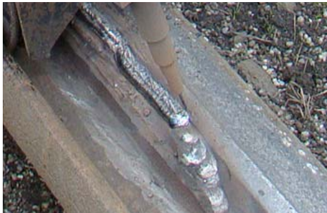
7. ábra Egymáshoz képest eltolt varratkezdési helyek. Javasolt a varratbefejezések hasonlóan lépcsős kialakítása.
