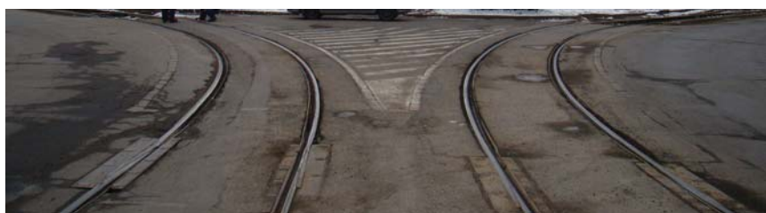
3. ábra Beépített Phoenix sínek
