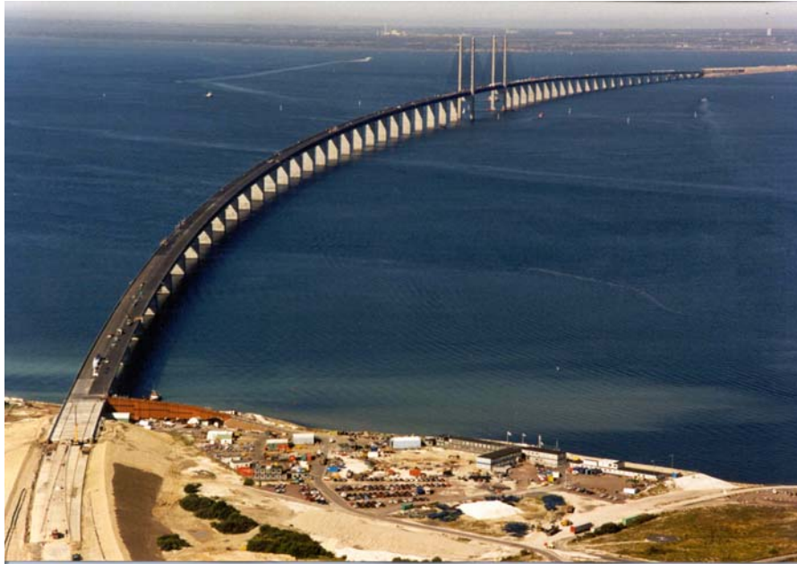
5. ábra Az Öresund híd építése.
